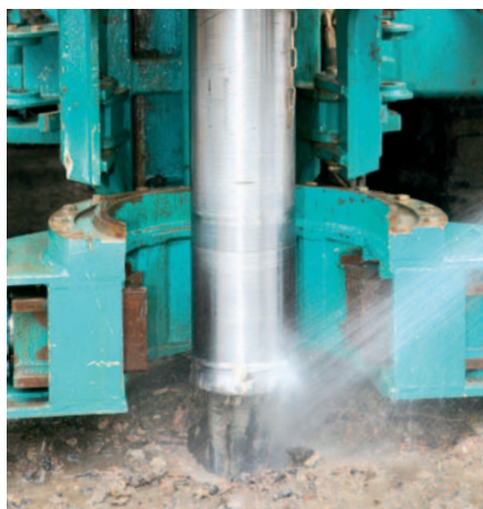
Odwierty pod sondy
